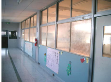
廊下から参観できるよう壁を除去
