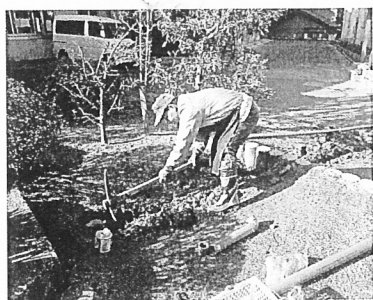
池の排水溝を修理していただきました
